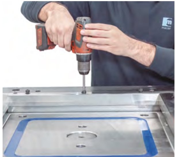
Figura 4.23. Proceso de montaje de las cuchillas intercambiables rectificadas (3).
