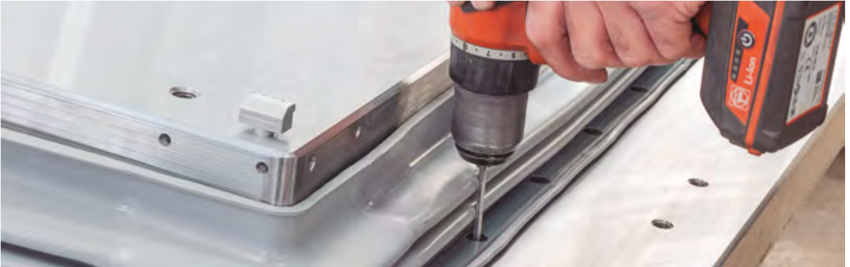
Figura 4.13. Montaje del fuelle.
